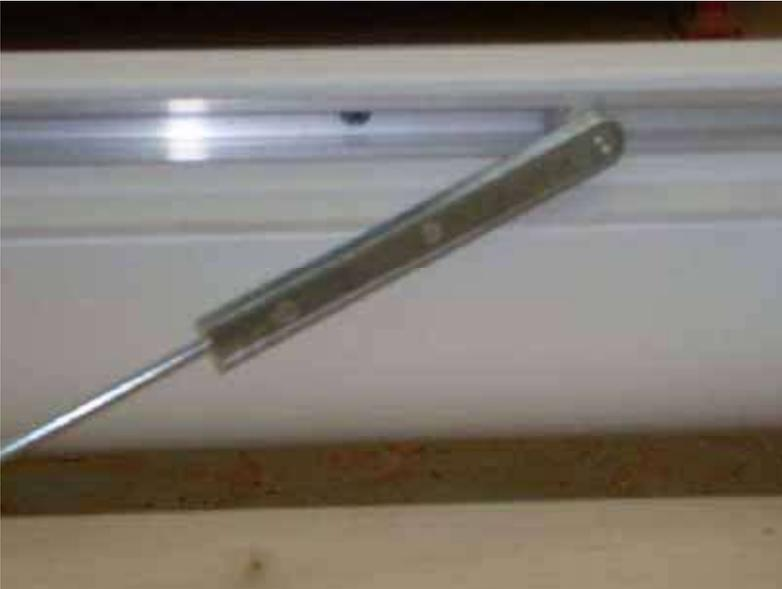
Il braccetto con l'oliva in nylon va smontato per inserirlo nella guida del traverso prima di assemblare lo stipite e installarlo nel foro muro di posizionamento
