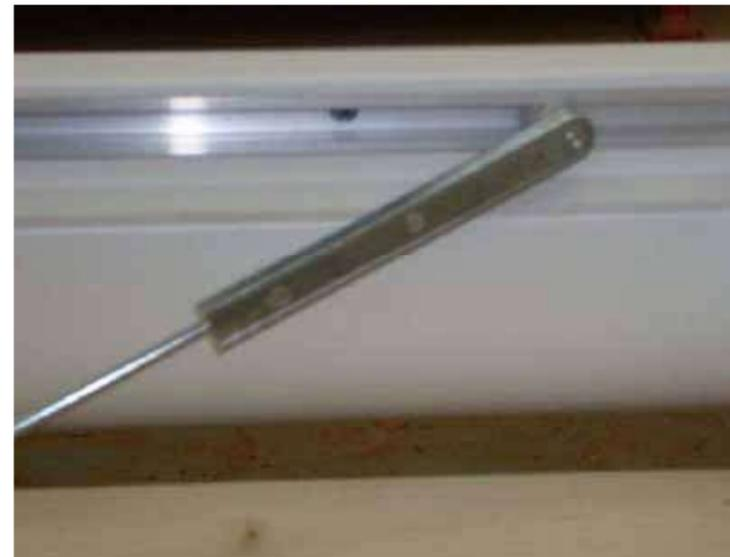
Il braccetto con l'oliva in nylon va smontato per inserirlo nella guida del traverso prima di assemblare lo stipite e installarlo nel foro muro di posizionamento
